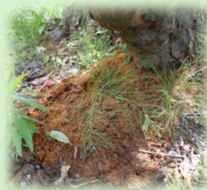
幼虫が出したフラス
