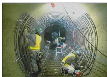
更正工法（鋼製リング施工）
