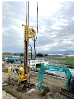
既存海岸堤防上での施工状況
