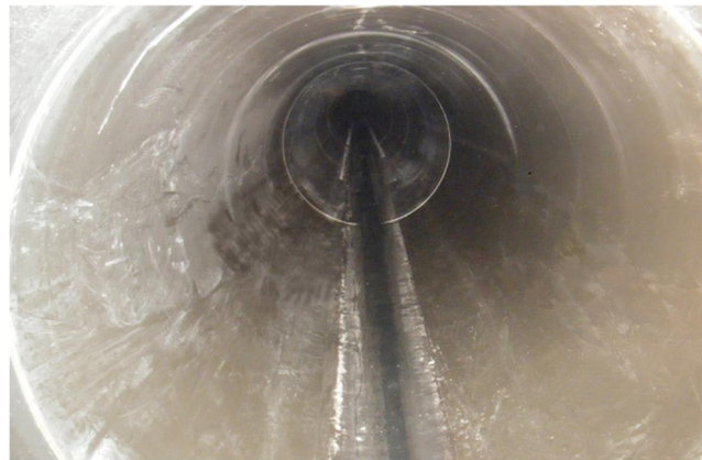
新設管内状況
