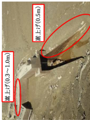
写真 土砂吐ゲート(φ300)
