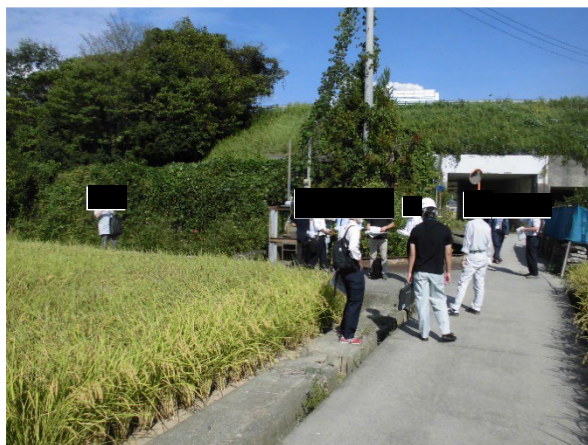
和歌山電鉄橋梁横断部
