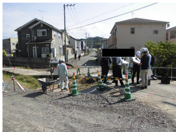
推進発進立坑部
