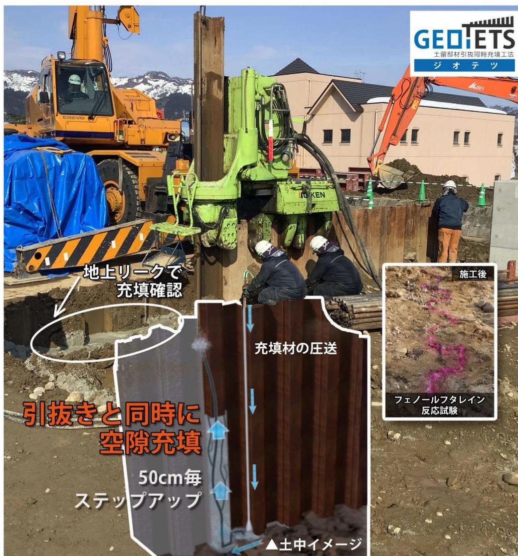
図 1. 土留部材引き抜き同時充填(GEOTETS)工法の概要
