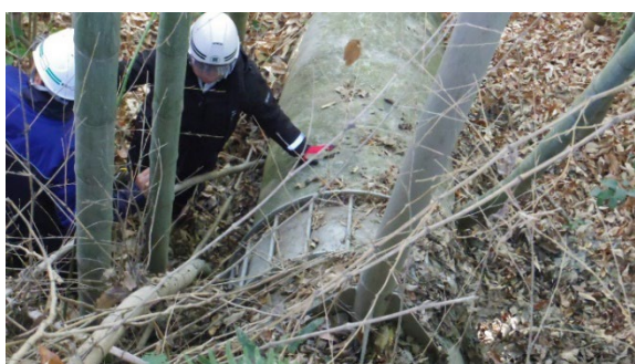
斜面配管上部ジョイントの状況調査
