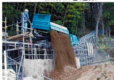
法面防災工事で 1500m 3 の土砂を運搬
