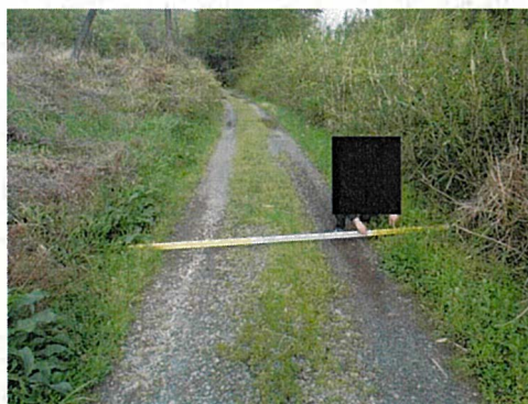
写真. 狭隘部(幅員 2.2m)
