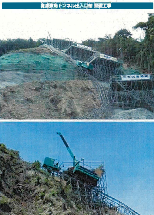
▲ CP-447E1による土砂・重機搬入・搬出 (レール長120m 平均傾斜40度 最大傾斜60度 搬出土砂2,000m 3 )
