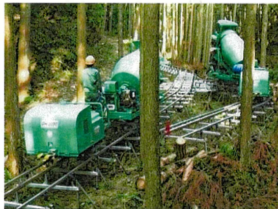
写真. コンクリート打設状況
