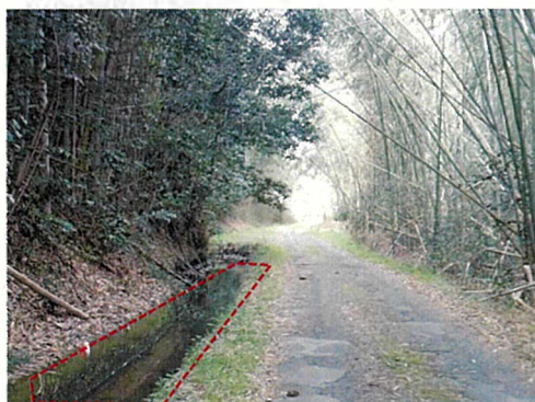
写真. 進入路沿い水路
