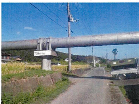
写真. 既設水管橋横断部
