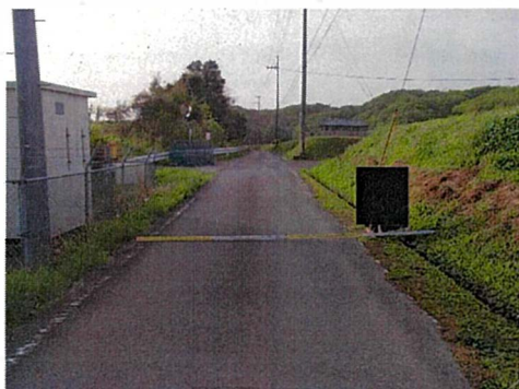
写真. 狭隘部(幅員 3.0m)
