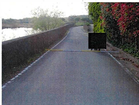
写真. 家屋と擁壁に挟まれた箇所(幅員 3.4m)
