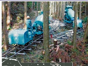
鉄塔建替工事で30m 3 /日の 生コンを1000m以内運搬可能
