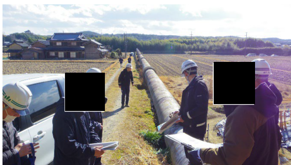
斜面下（仮置きヤード予定地付近）
