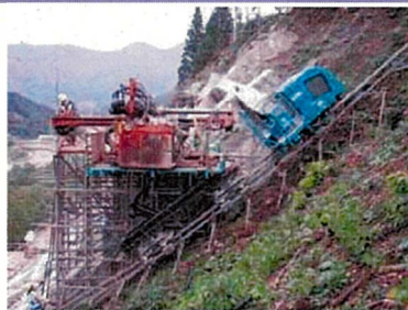
地滑り対策工事で 3トン掘削機を運搬
