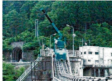
ダム設備増設工事で ダム側壁クレーン作業
