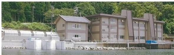
余呉湖第二補給揚水機場 (左) ・余呉湖補給揚水機場 (右)
