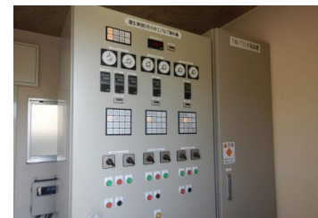
蒲生東部5号分水工 TM/TC子局装置 (県造施設)
