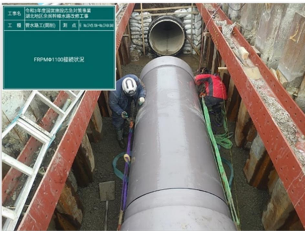
余呉幹線水路管布設状況（開削区間）
