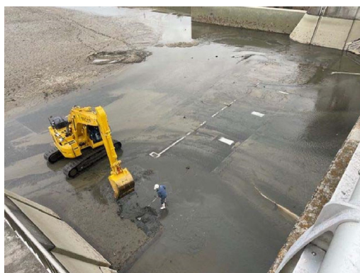
河川内工事の一例(土砂撤去)
