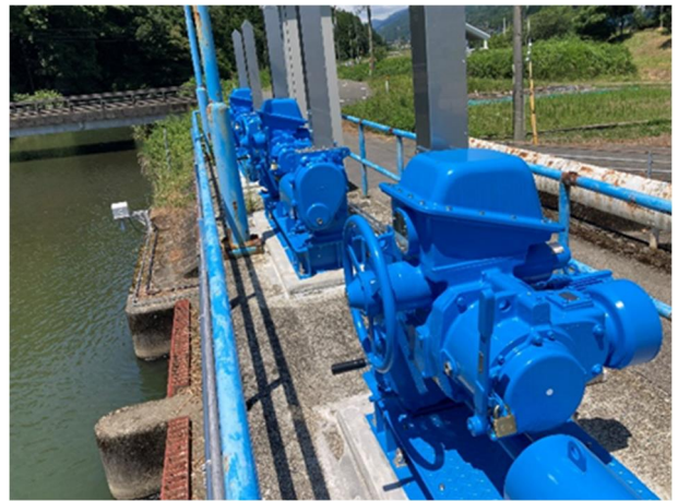
取水ロケット開閉装置更新完了 （余呉川頭首工）
