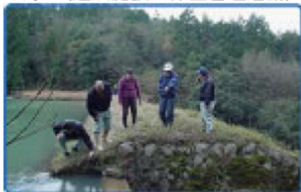
ため池の点検
