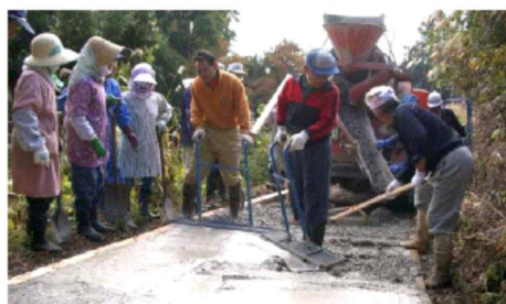
道路を住民がコンクリート舗装
