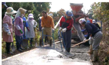
道路を住民がコンクリート舗装
