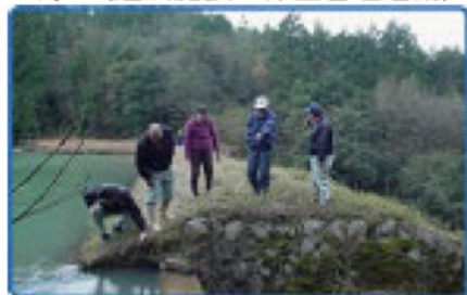
ため池の点検
