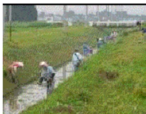
水路の泥上げ
