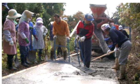
道路を住民がコンクリート舗装
