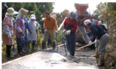
道路を住民がコンクリート舗装
