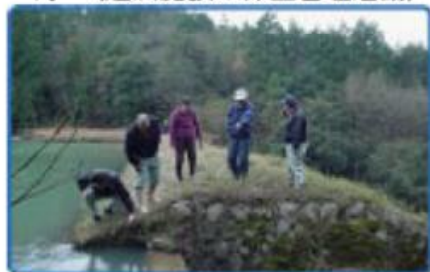
ため池の点検
