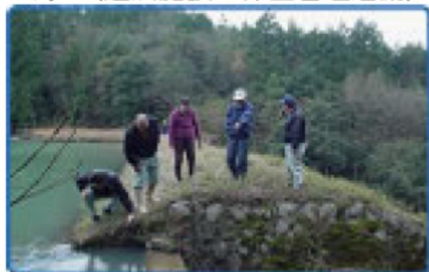
ため池の点検
