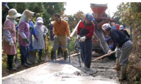
道路を住民がコンクリート舗装
