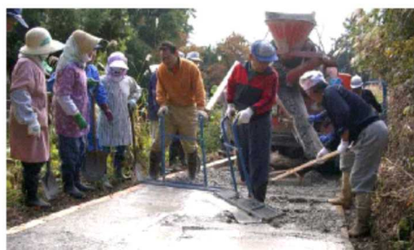
道路を住民がコンクリート舗装
