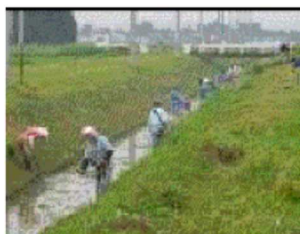
水路の泥上げ
