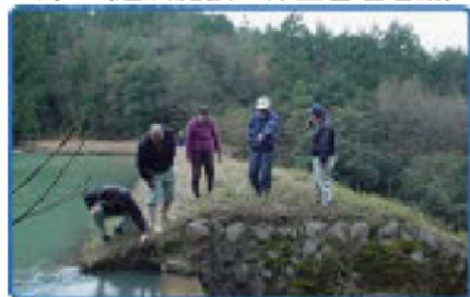
ため池の点検
