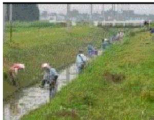
水路の泥上げ
