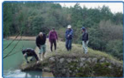
ため池の点検
