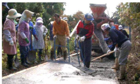
道路を住民がコンクリート舗装
