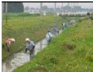
水路の泥上げ
