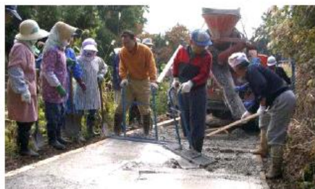
道路を住民がコンクリート舗装
