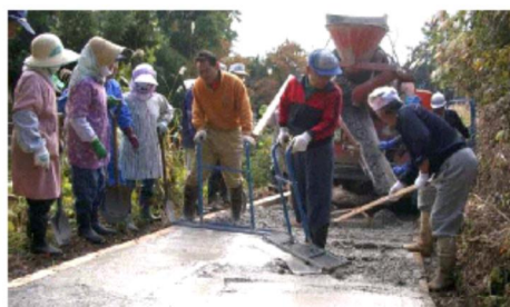
道路を住民がコンクリート舗装
