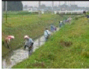
水路の泥上げ
