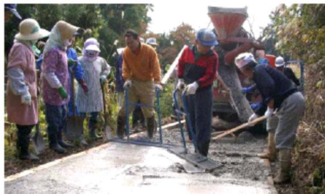
道路を住民がコンクリート舗装
