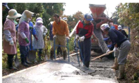
道路を住民がコンクリート舗装
