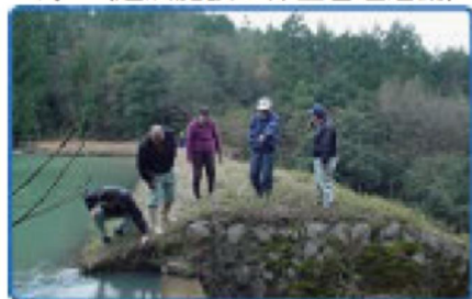
ため池の点検
