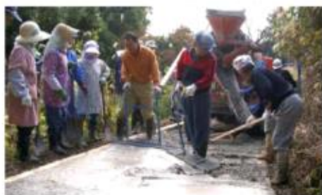
道路を住民がコンクリート舗装
