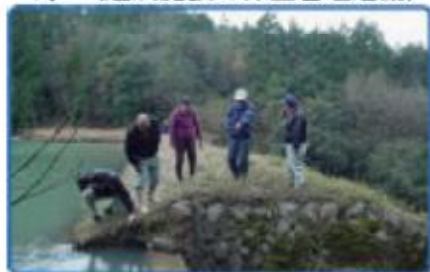
ため池の点検
