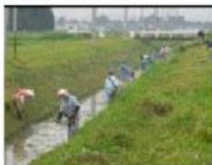
水路の泥上げ
