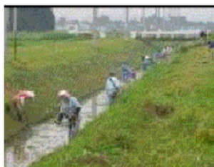
水路の泥上げ
