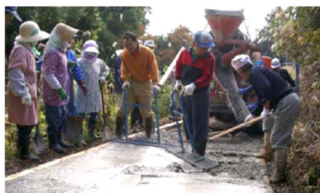
道路を住民がコンクリート舗装
