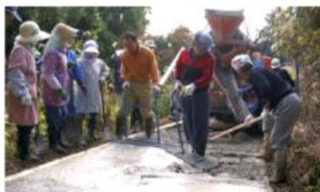
道路を住民がコンクリート舗装
