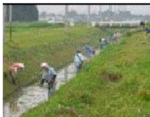
水路の泥上げ
