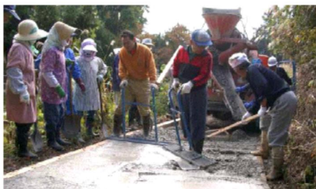
道路を住民がコンクリート舗装
