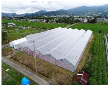
局所空調システムを導入したハウス
