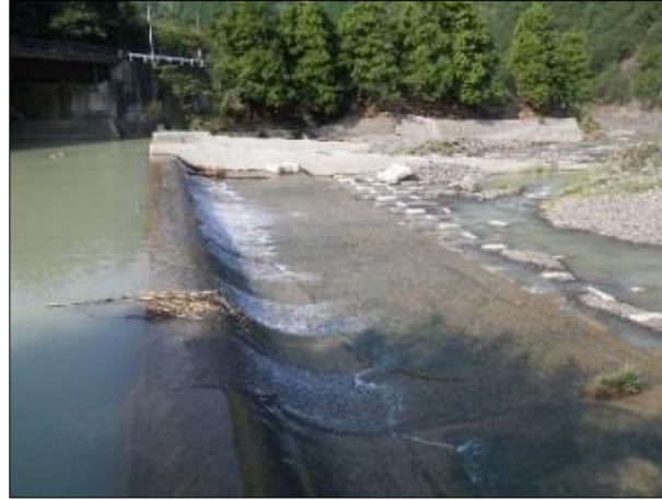
へがわ 辺川頭首工
