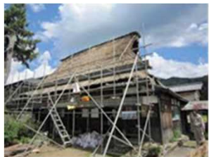
古民家改修の様子
