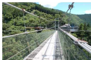
谷瀬の吊り橋
