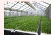
農業生産施設（水耕栽培ハウス）
