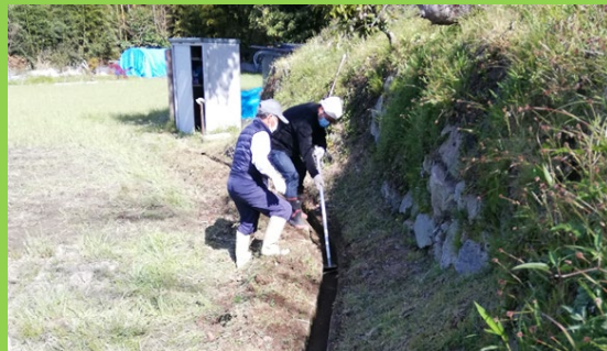
水路の維持管理
