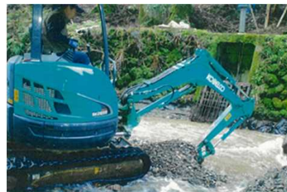
【バックホーを使った浚渫作業】
