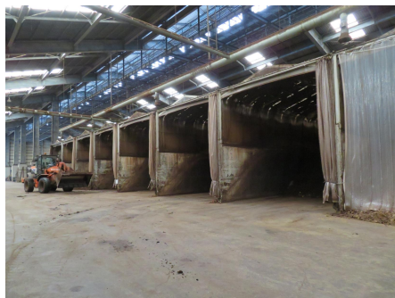
4区画での処理を経て、養生槽へ (1区画あたり約1週間堆積発酵・通風)
