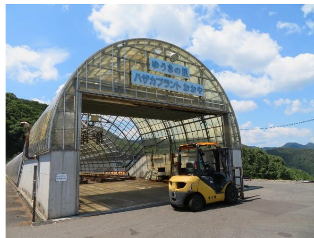
ハザカプラントの堆肥化処理施設
