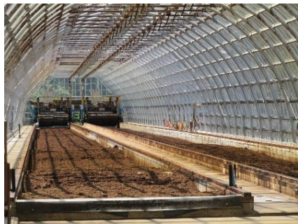
2レーン（深さ2m）に原料投入 1日1回攪拌（4m進む）
