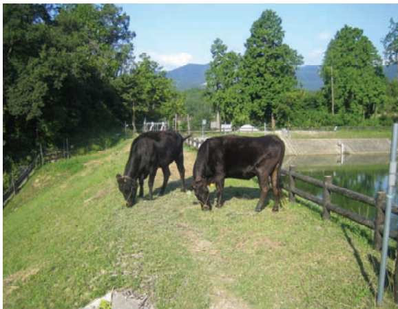
写真12. ため池堤体（滋賀県）
