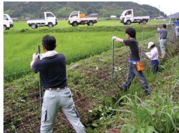
【防護柵の設置】
