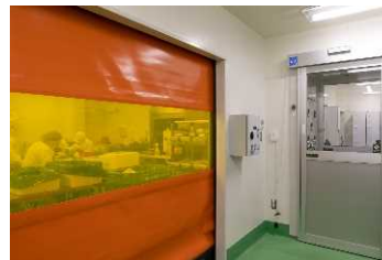
HACCP対応新設工場
