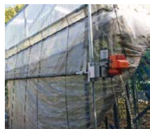
①自動換気装置
