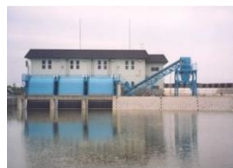
排水機場の整備
