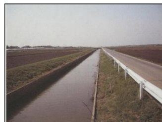
排水路の整備
