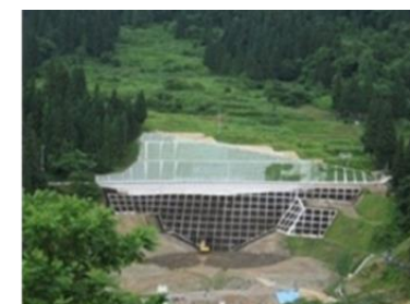
地すべり対策工事の完了
