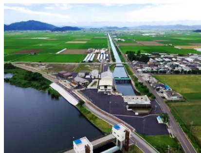
排水施設の整備(排水機場)
