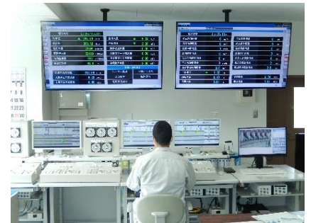
施設の管理(ダム)
