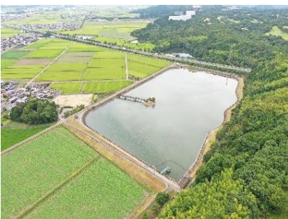
用水施設の整備(調整池)
