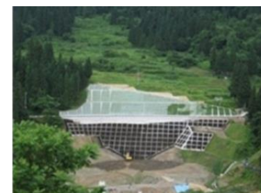
地すべり対策工事の完了
