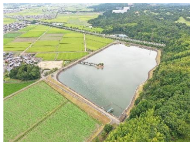
用水施設の整備(調整池)
