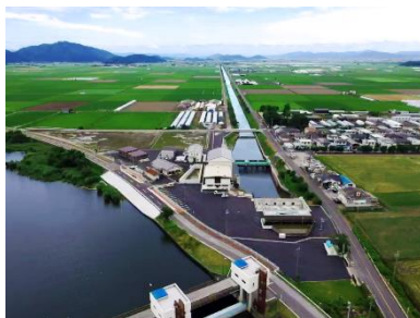
排水施設の整備(排水機場)
