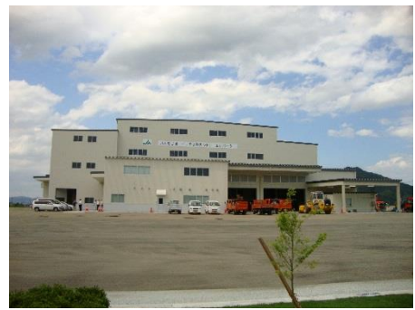
ブランド米に対応した穀類共同乾燥調製貯蔵施設（兵庫県豊岡市）
