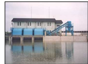
排水機場の整備
