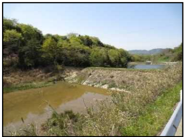
整備前のため池
