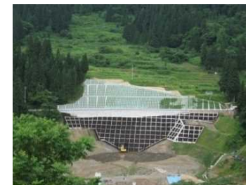
地すべり対策工事の完了
