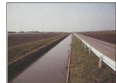
排水路の整備
