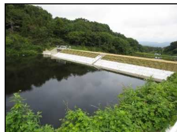
整備後のため池
