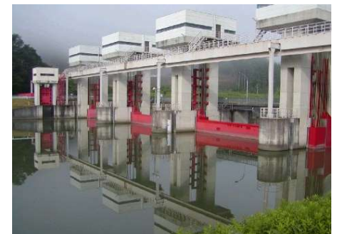
川代ダム (H3完成、ゲート式ダム)
