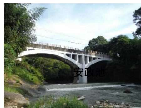
御坂サイフォン（水路橋）の耐震化 (※世界かんがい施設遺産)
