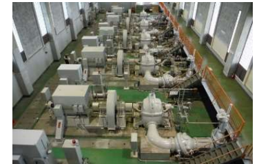
第1段揚水機（ポンプ）の更新
