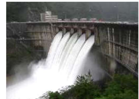
国営造成施設の調査・管理等 の実施
