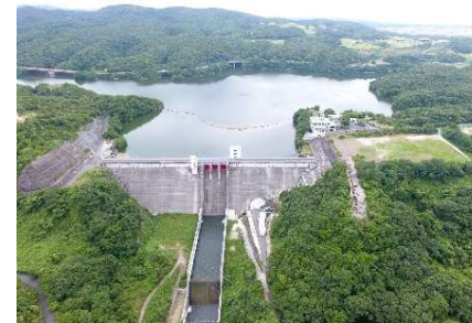
吞吐ダム (H4完成、重力式コンクリートダム)
